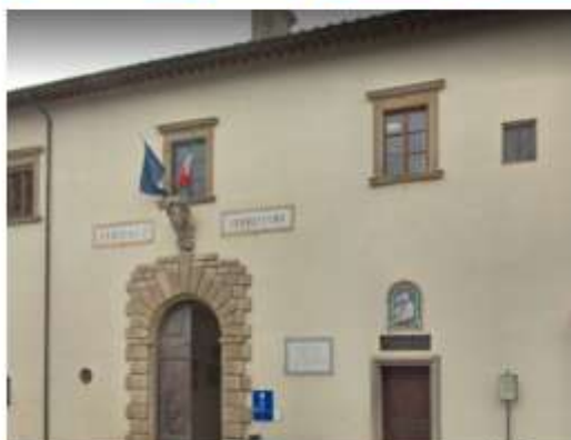
L'antico ingresso dell'Ospedale Serristori
